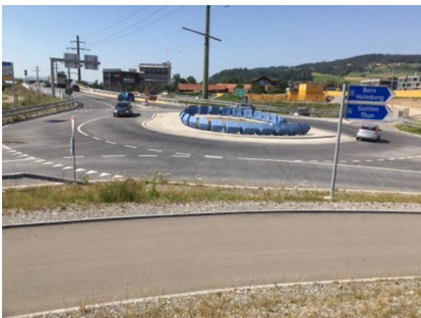
Der Turbokreisel – der zweite in der Schweiz - in der Glättmühle: - Er erfüllt die in ihn gesetzten Erwartungen bezüglich der Kapazität voll und ganz. - Nachts sind die blauen Elemente dezent von innen beleuchtet!
