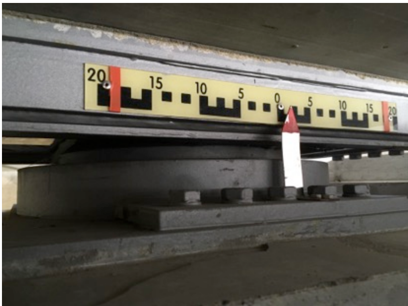
Fachleute können auch aus dieser Skala beim Brückenlager die Temperatur ablesen!
