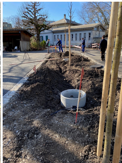
Nachher: Schwammstadt-Aufbau, sickertfähige Oberflächen, Bäume
