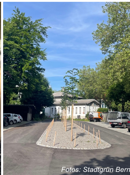
Nachher: Schwammstadt-Aufbau, sickertfähige Oberflächen, Bäume
