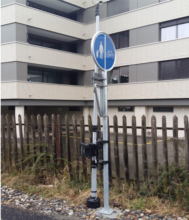
Abb. 5: Erhebung mit Videoerfassungsgerät in Luzern. Die Stärken von Methoden, die mit digitalen Videos arbeiten, liegen in der universellen Erfassungsmöglichkeit aller Verkehrsmittel. Bild: ewp
