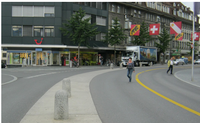
Abb. 5: Spezialfahrbahnen wie separate Busstreifen erschweren das Queren, sind aber kein Ausschlusskriterium für flächiges Queren (Thun Bahnhofstrasse)
