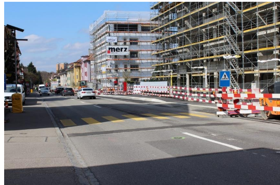
Könizstrasse derzeit im Bau (beidseitig neu mit Radstreifen 1.8m)
