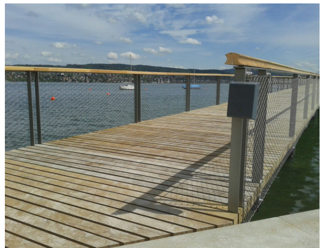
Fig. 1 : Compteur permanent des piétons (capteur infrarouge). Cet appareil se caractérise par une précision élevée et un usage mobile. Ici, comptage du nombre de piétons sur la nouvelle passerelle Cassiopeia à Zurich. Source : Stadt Zürich, Tiefbauamt
